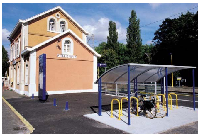
Abri-vélo en gare
