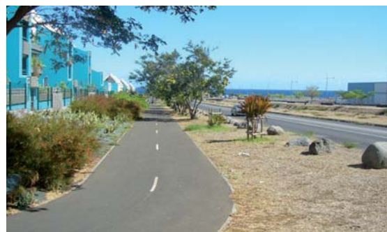
Piste éloignée de la chaussée
